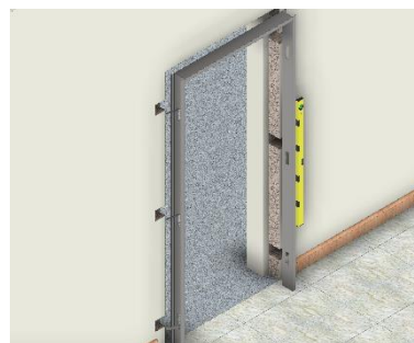
Fig. 1.8 – Assentar e nivelar o pré-aro (nível de bolha de ar com base magnética)
